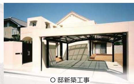
K邸新築工事
