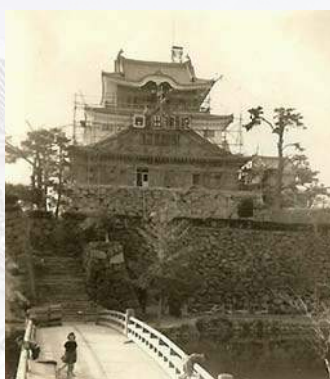
岸和田千亀利城天守 再建工事 (昭和29年11月)
